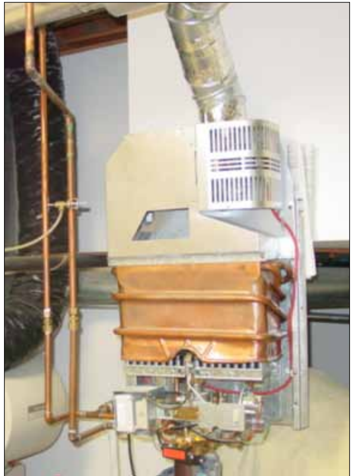
Intérieur d'un chauffe-eau à gaz naturel sans réservoir
