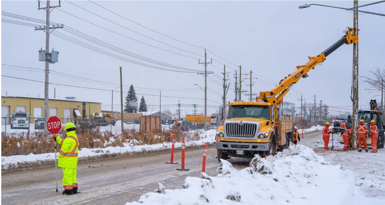
Une équipe s'emploie à rétablir le service à la suite d'une collision entre un véhicule et un poteau d'électricité à Winnipeg.
