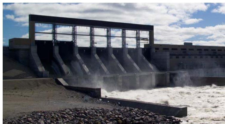
La centrale de Limestone
