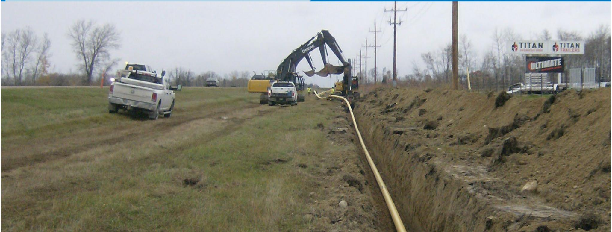
**L'excavation de tranchée** consiste à creuser un trou long et étroit dans le sol et à y placer le pipeline.
