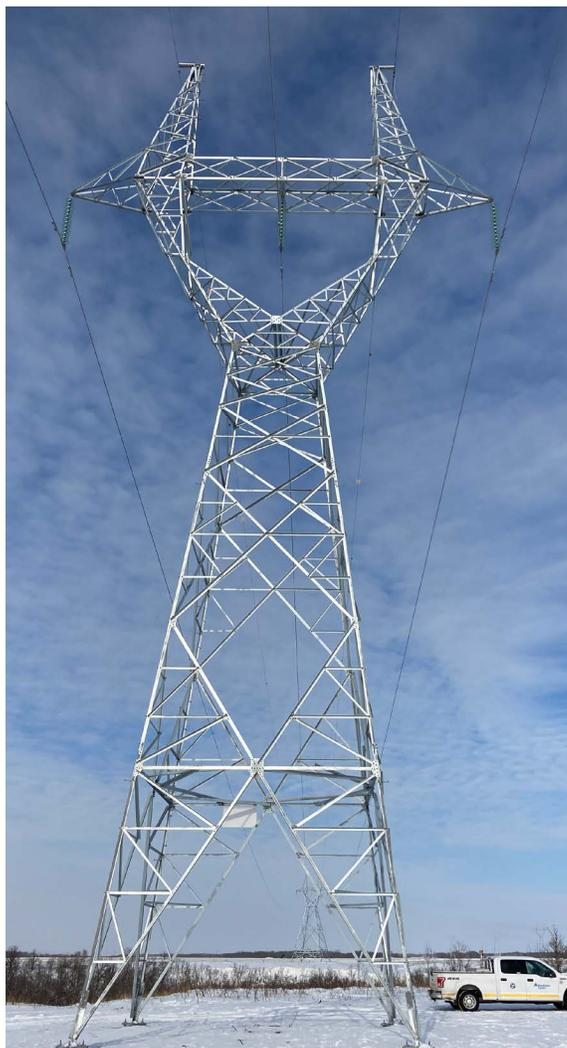
Le projet de transmission de Birtle comprenait la construction d'une ligne de transmission de 230 kV entre la centrale de Birtle, au sud de la communauté de Birtle, et la frontière entre le Manitoba et la Saskatchewan.
