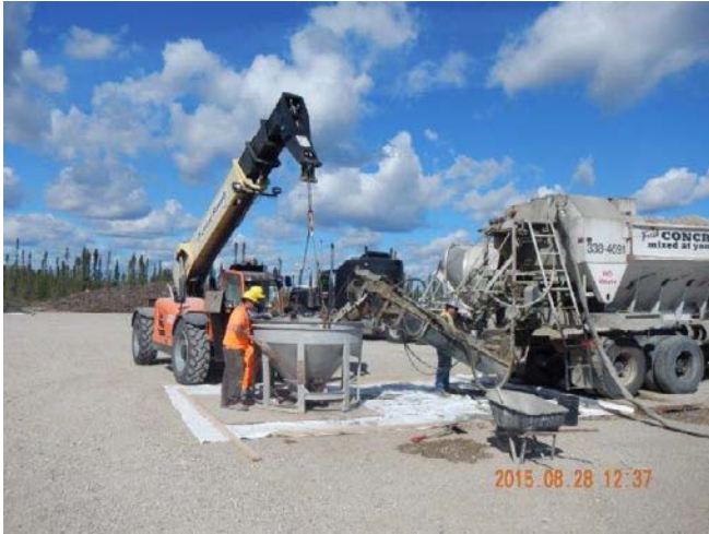
Photo 4: Keewatinohk Converter Station – Concrete pour
